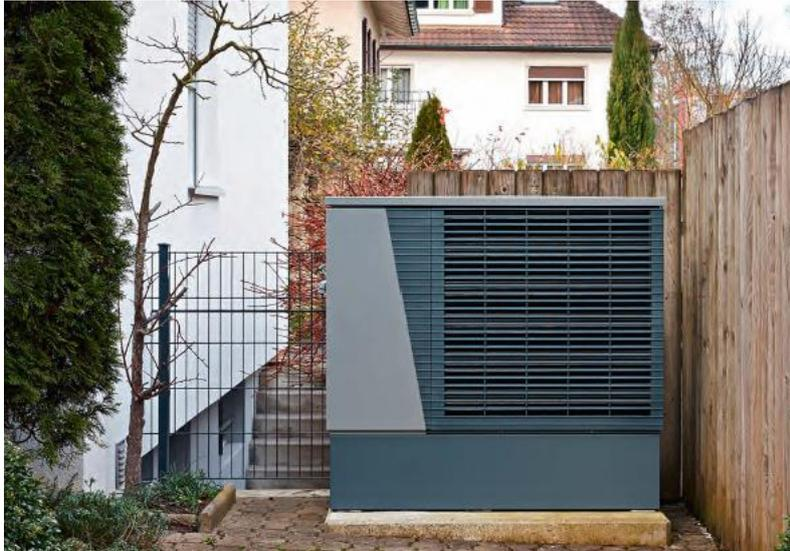
Bild: Aussen aufgestellte Luft/Wasser-Wärmepumpe
